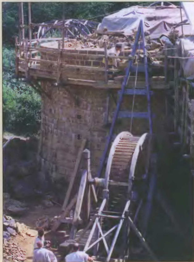
Staveniště Guédelon v Burgundsku
